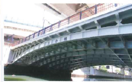
風情のあるアーチ橋。上流は「中村川」、下流は「堀川」と橋を境目に川の名前が変わる地点でもある。
