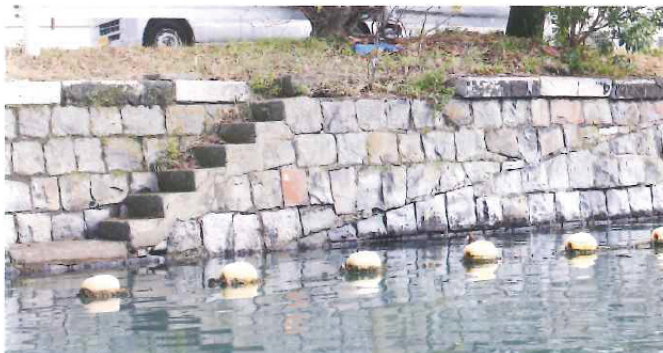
横浜の水運、治水対策に貢献し、また、当時の面影を残す長大な石積護岸は、平成22年度土木学会選奨土木遺産に認定された。撮影:豊田直之
