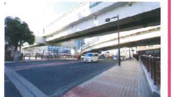
山下町方面と元町・石川町を結ぶ主要交通路の一部でもある。橋の上空は首都高速狩場線の高架橋。
