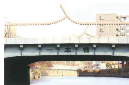
「人」という文字がデザインされているユニークな高欄。建築家、澁川豊一による1988(昭和63)年の制作。
