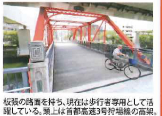
板張の路面を持ち、現在は歩行者専用として活躍している。頂上は首都高速3号狩場線の高架。
