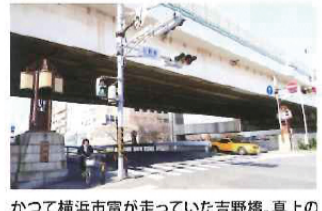
かつて横浜市電が走っていた吉野橋。真上の高速道路と川の下地鉄もここで交差する。
