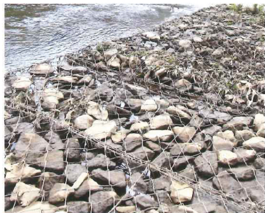
中里橋付近の河川浄化システム。エビやカニなど、水棲小動物や苔などを増やすことで浄化効果をもたらしている。撮影：豊田直之
