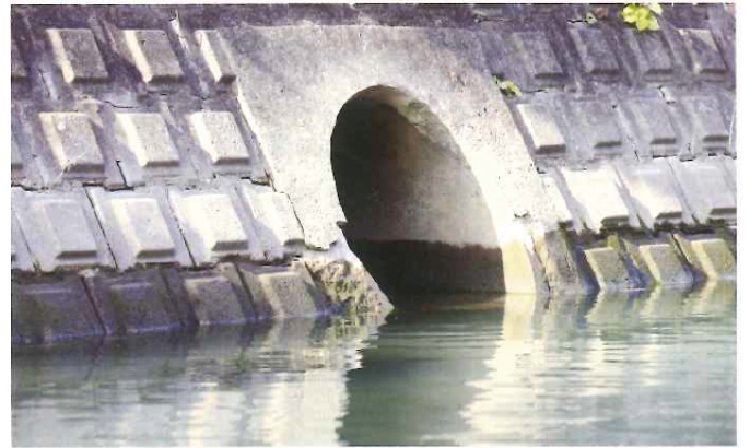
大岡川に流れ込む雨水管の排水口。側溝に入ったゴミは、ここから流出している。排水口を一時的に網などを設置して、流出するゴミの量を確認してみたいと考えている。
