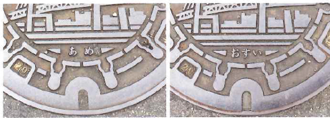
分流式の下水マンホールには、よく見ると「あめ」「うすい」「おすい」などが明記され、下を流れる排水が、どんな水なのかかわかるようになっている。
