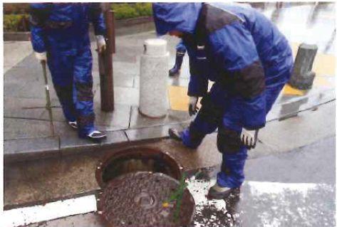
見学させていただいた雨水マンホールは深さ4mほどもあり、底を静かに水が流れていた。真っ暗で、地上からのゴミの確認は難しい。
