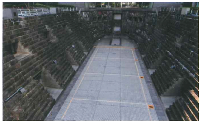
国重要文化財に指定された『旧横浜船渠第2号ドック』。プロジェクションマッピングが毎日開催されている。 撮影:豊田直之
