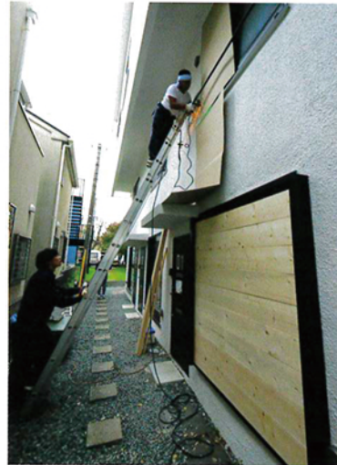
加速的に凶悪化する台風を見据え、台風接近時に平板を取り付けて窓ガラスを守る造作作業が終了しました。
